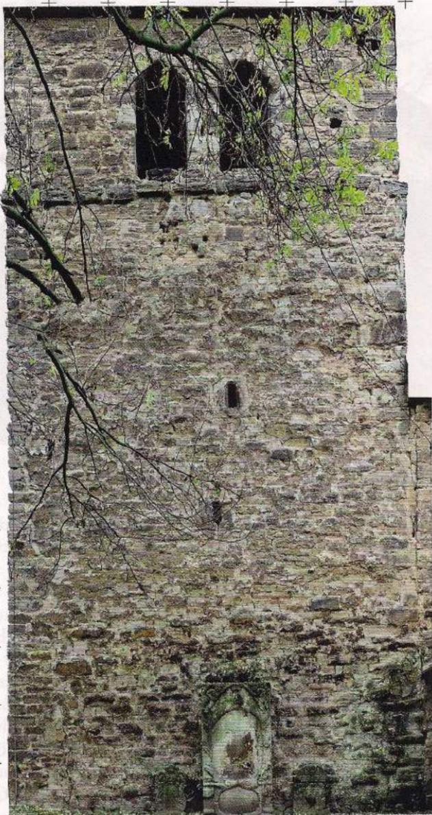
Abb. 3: Entzerrtes Orthofoto der Südfassade des Turmes mit sekundär ansetzendem Kirchenschiff.
